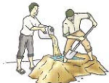
\* Colocamos la mezcla de barro en el sobrecreimiento, esta junta horizontal tendrá una altura de 2.5 cm, después asentaremos los adobes.
