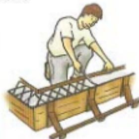
Al finalizar y antes de que el concreto endurezca, se debe robar la superficie, para que tenga mayor adherencia con el barro de la primera hilada.
