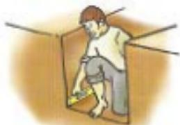
\* Las paredes laterales de la zanja deben ser verticales, para ello verificámos con la plomada.
