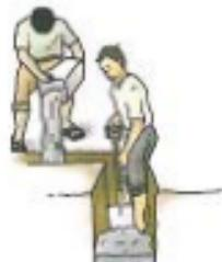
Luego celecamos manualmente la primera capa de piedras, y vaciamos concreto. Hay que asegurarse que las piedras siempre estén recubiertas por mezcla.
