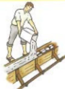
\* Acomodamos manualmente las piedras; vaciamos concreto y chuceamos asegurando una correcta distribución de la mezcla.
