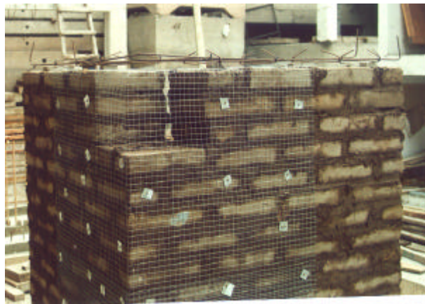
Fig. 4.- Diente en esquina para anclaje de viga solera y malla electrosoldada clavada al muro de adobe.
