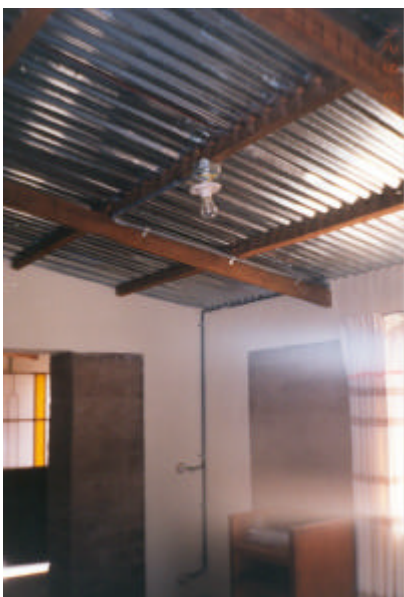
Fig. 17 y 18.- Interior de dos viviendas de adobe construida por el proyecto SENCICO-PNUD, se observa las tuberías de las instalaciones eléctricas por el exterior de los muros, incluyendo la caja de llaves.
