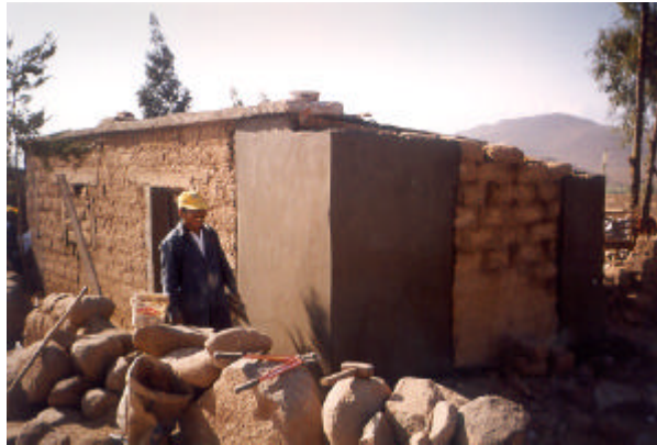
Fig. 6.- Curso práctico de reforzamiento de viviendas existentes de adobe. Tarrajeo de franjas de mallas electrosoldadas con mortero cemento:arena.
