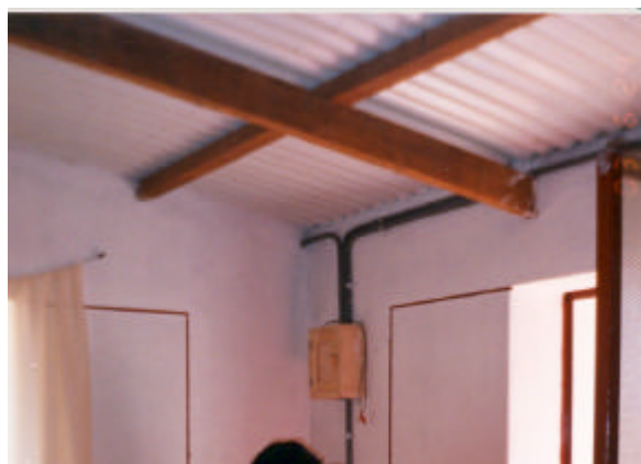
Fig. 17 y 18.- Interior de dos viviendas de adobe construida por el proyecto SENCICO-PNUD, se observa las tuberías de las instalaciones eléctricas por el exterior de los muros, incluyendo la caja de llaves.
