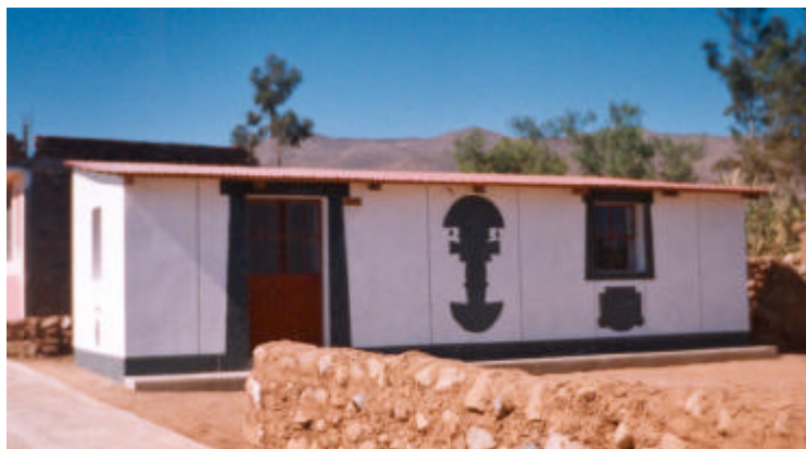
Fig. 16.- Vivienda de adobe construida por el proyecto SENCICO-PNUD
