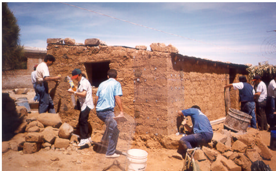
Fig. 5.- Curso práctico de reforzamiento de viviendas existentes de adobe. Instalación de mallas electrosoldadas en franjas verticales en las esquinas y horizontales en la parte superior de muros.
