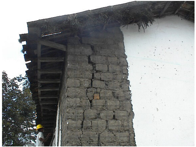
Colocación malla electrosoldada
