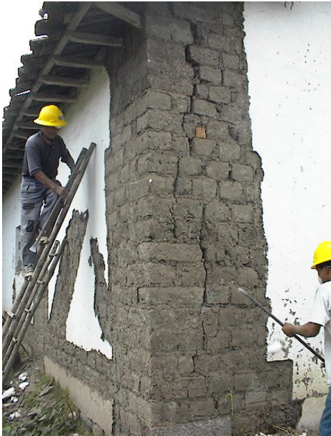
Preparación del muro.
