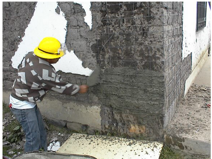
Recubrimiento de la malla con mortero.
