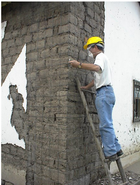
Sujeción de la malla con conectores.
